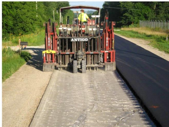
Modified Rubblization-occasional spalling
