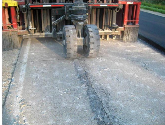
Modified Rubblization-occasional spalling
