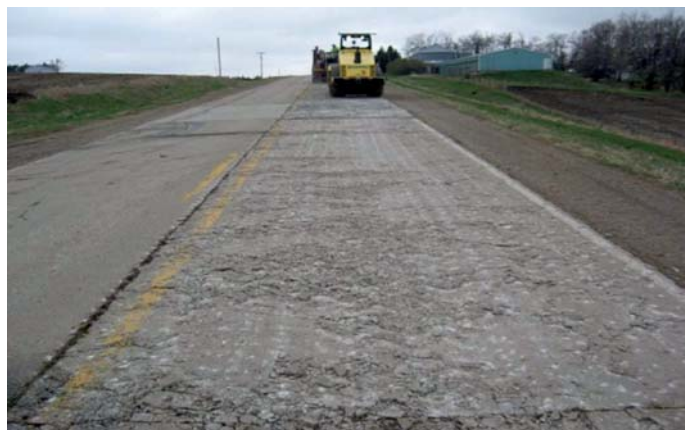
Fot. 12. Powierzchnia pasa nawierzchni betonowej po połamaniu – rubblizing zmodyfikowany oraz w czasie wałowania walcem okrętowym
