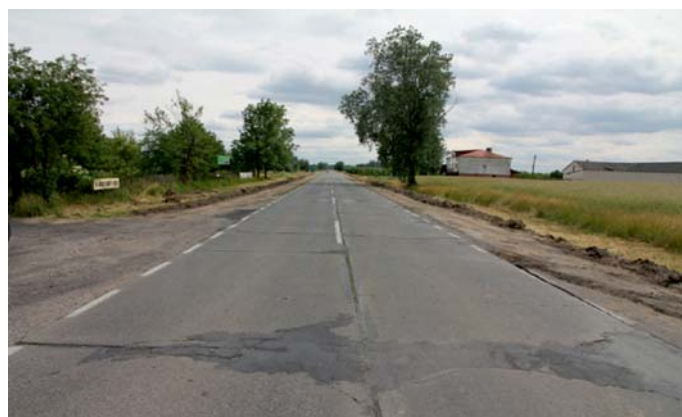
Fot. 3. Droga wojewódzka nr 801 w okolicy miejscowości Wilga – stan sprzed wykonania kruszenia udarowego nawierzchni (czerwiec 2016) [3]
